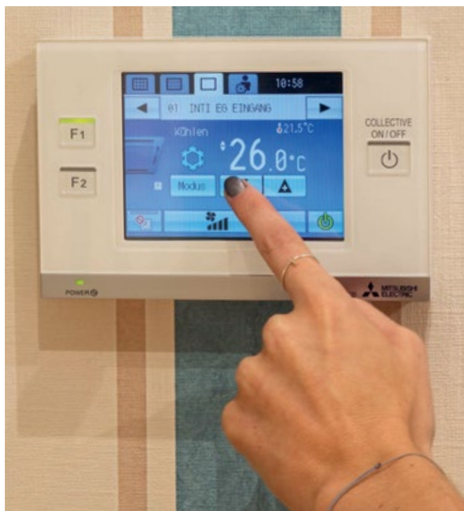
Über die zentrale Steuerungseinheit können alle Innengeräte über einen farbigen 5-Zoll-Touchscreen aus gesteuert und bei Bedarf an- oder ausgeschaltet werden.
